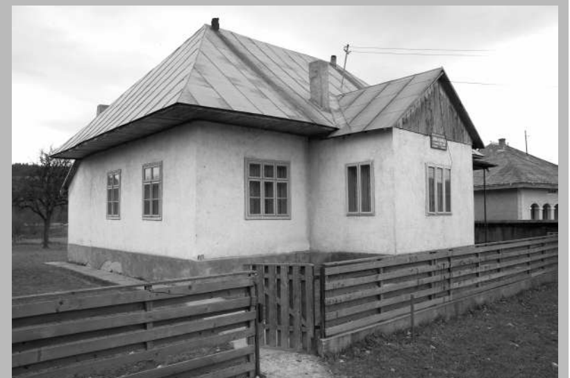
„Școala veche” de la Suha, construită în anul 1935
